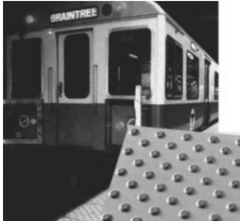
Foto 13. Citlivý prvok na úrovni nástupišta
