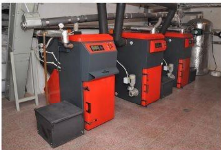
Pension Bejkův Mlýn Kaskáda automatických kotlů VERNER
