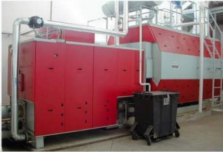
Spálenský – dřevěné lišty VERNER GOLEM 1 800 kW
