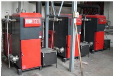
Poliklinika Broumov Kaskáda automatických kotlů VERNER
